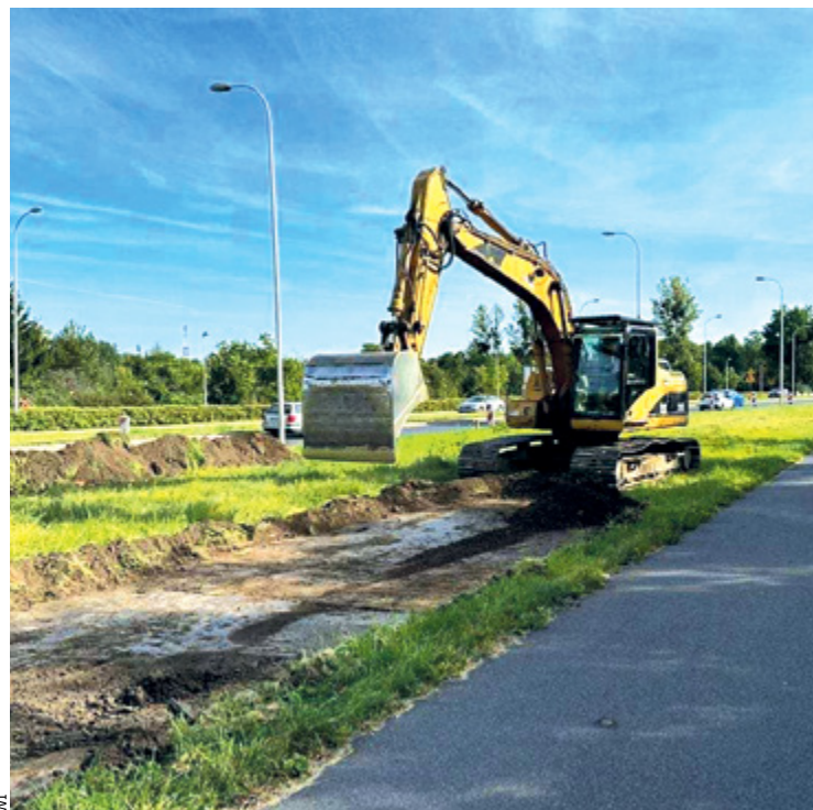
Prace ziemne pod nową wydzieloną trasą zostały rozpoczęte
